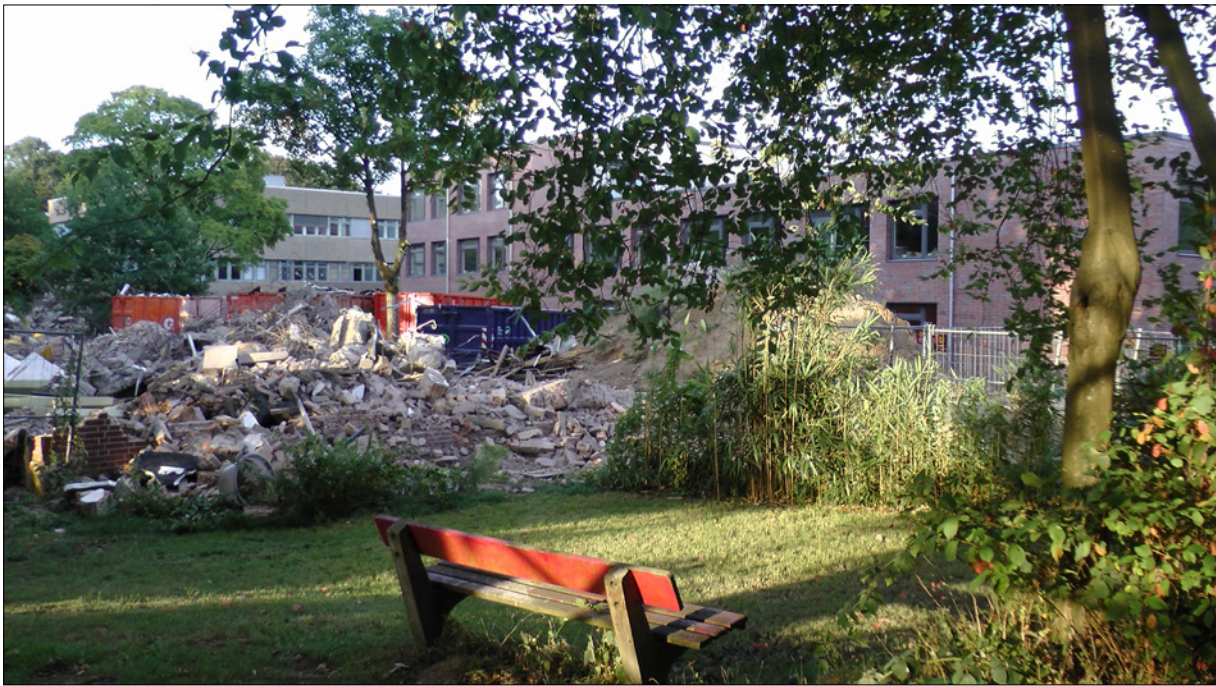
Der Schulgarten - noch direkt neben der Baustelle.
